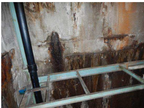
Foto 1: Průsaky vody pod břitem studny
