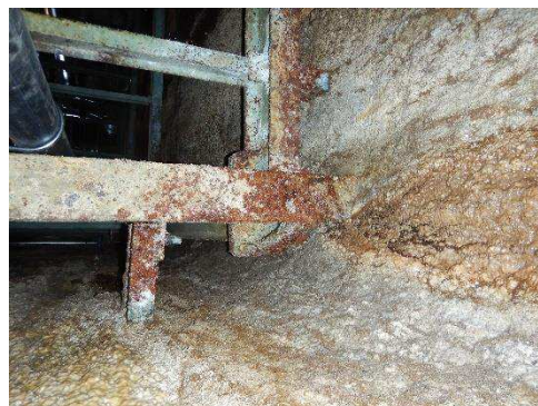
Foto 2: 6.PP – koroze kotvení OK
